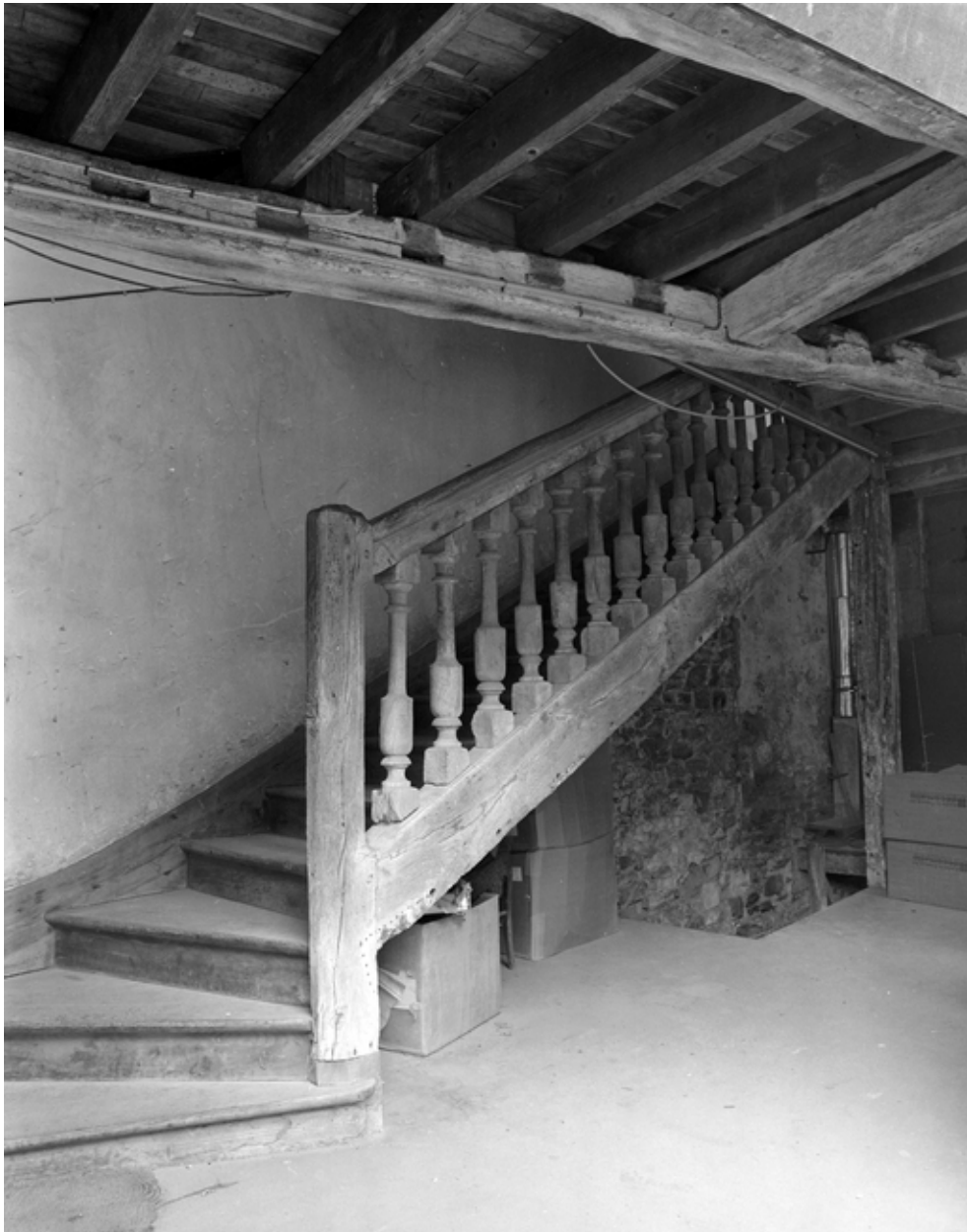
Escalier du corps latéral droit, vue générale.
