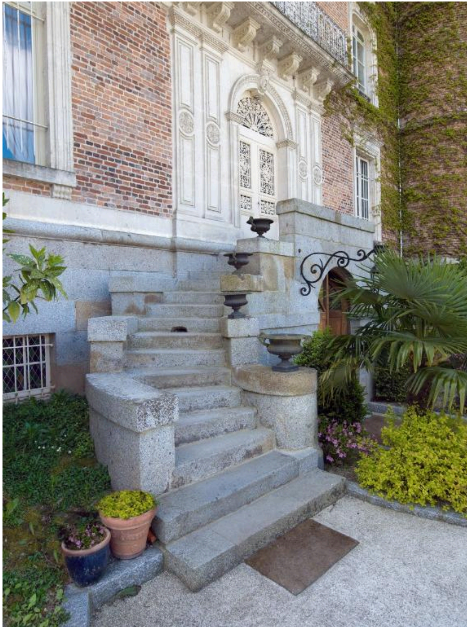
Détail de l'escalier de la façade nord
