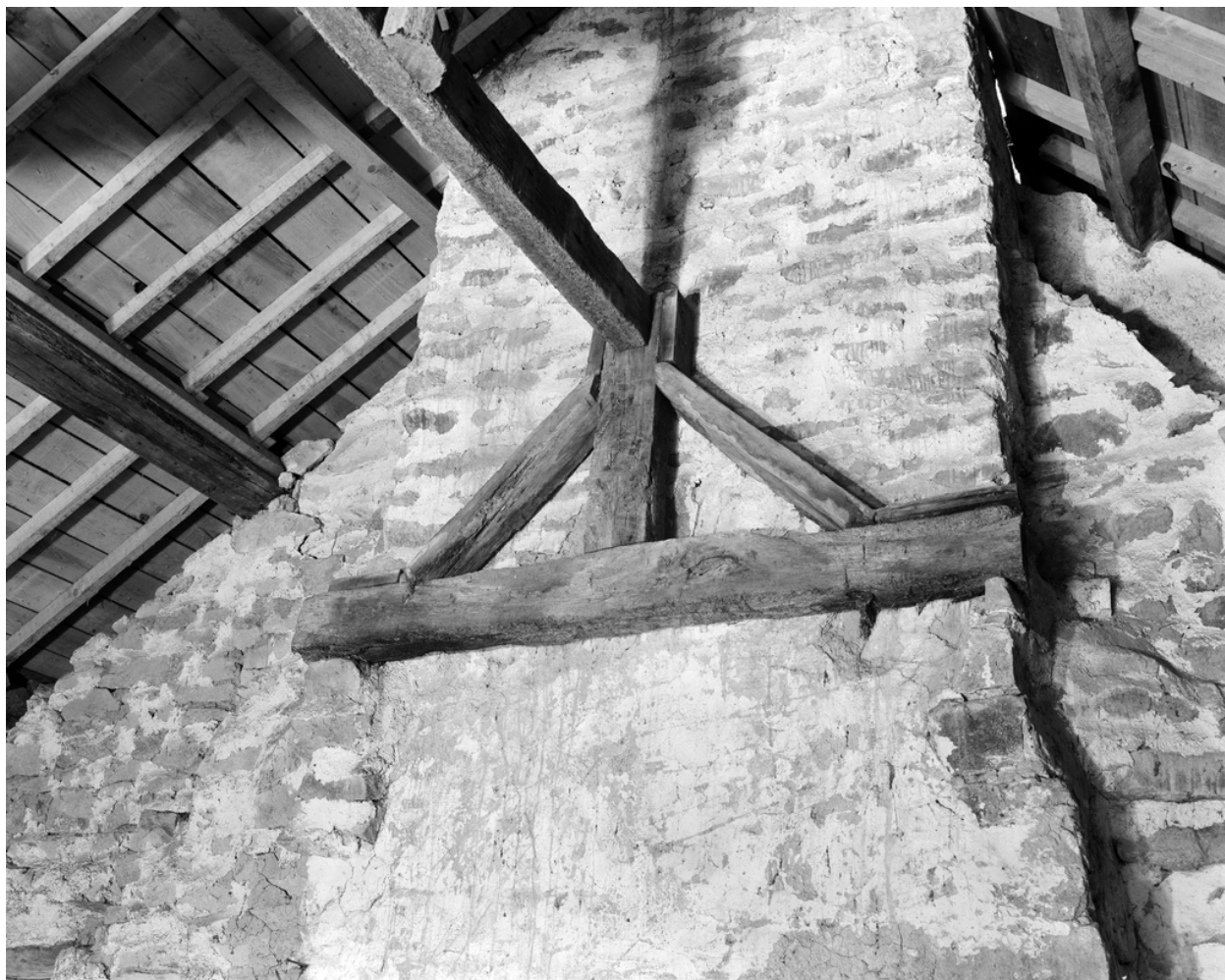
Charpente, détail du système de soutènement.
