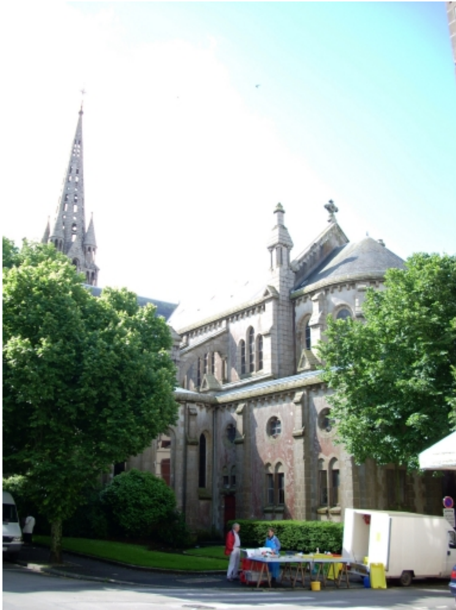
Brest, église Saint-Martin : vue générale sud-est
