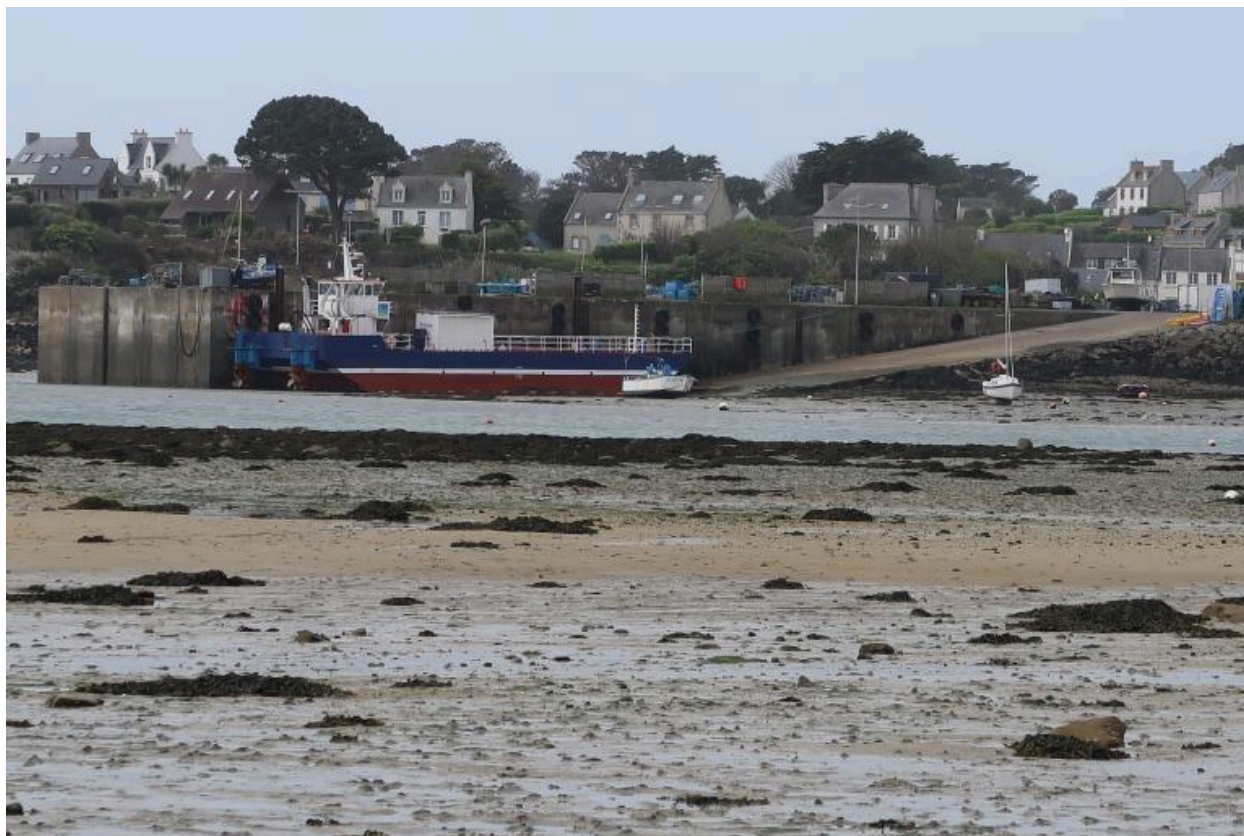
Vue générale du quai et de la cale de vil vihan (côté est)
