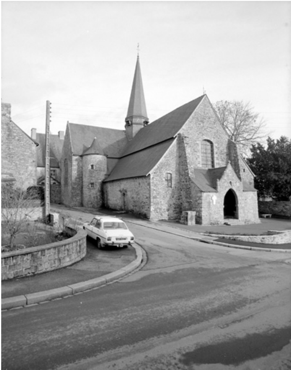
Elévation Nord-Ouest : vue générale
