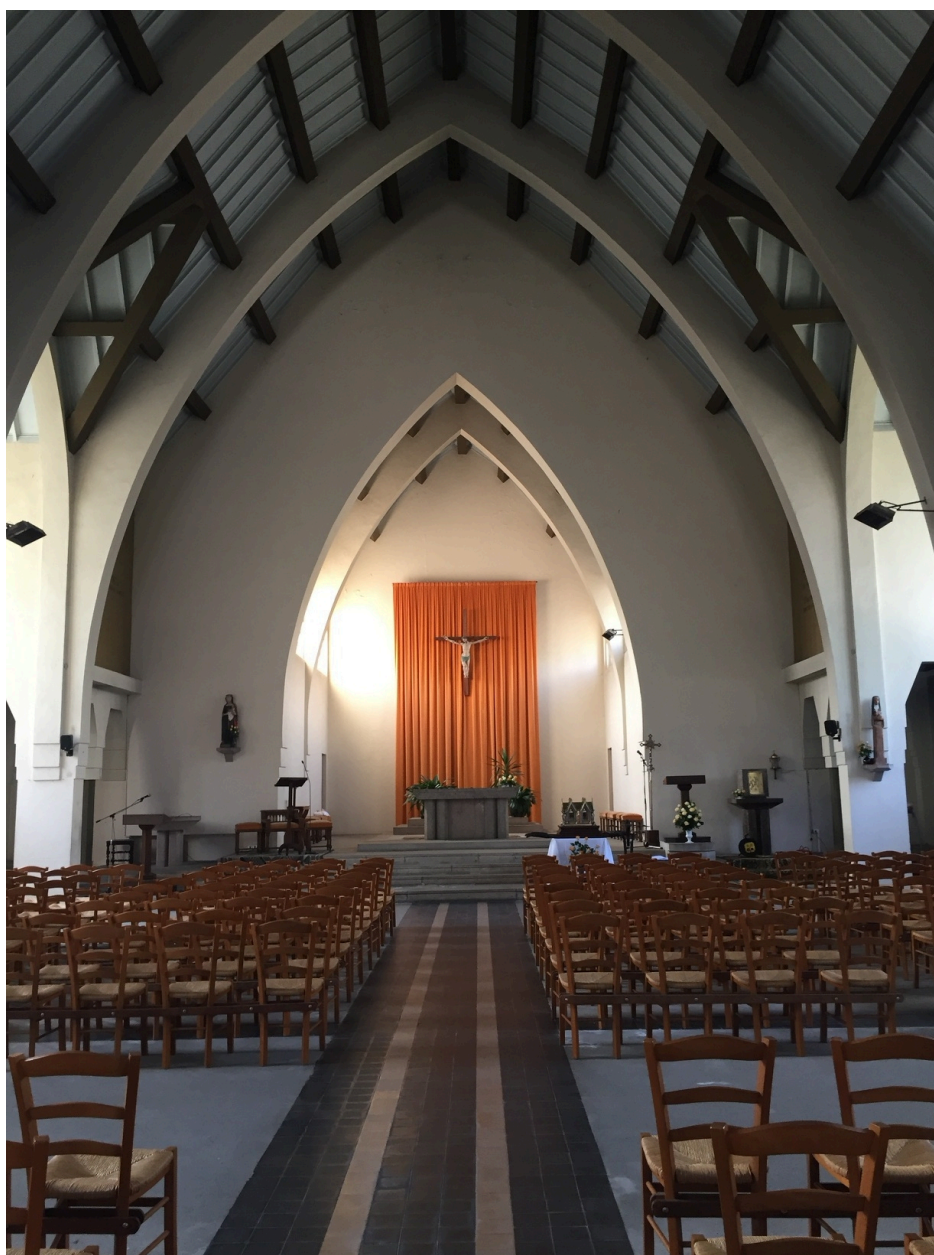
Vue intérieure grands arcs-doubleaux de béton pour la nef
