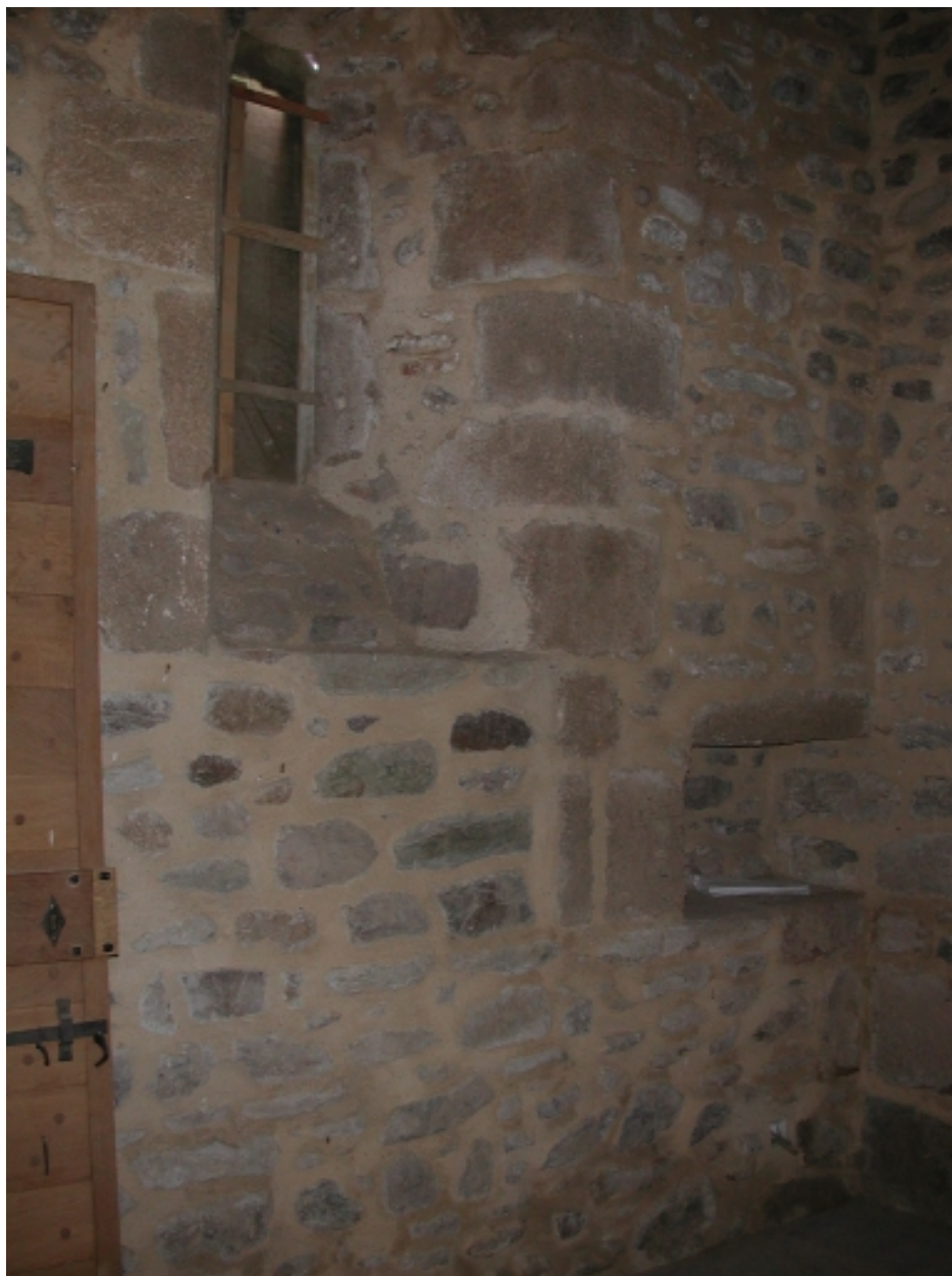
Vue intérieure du mur Ouest de refend : remarquer l'ouverture du type fenêtre meurtrière et la niche
