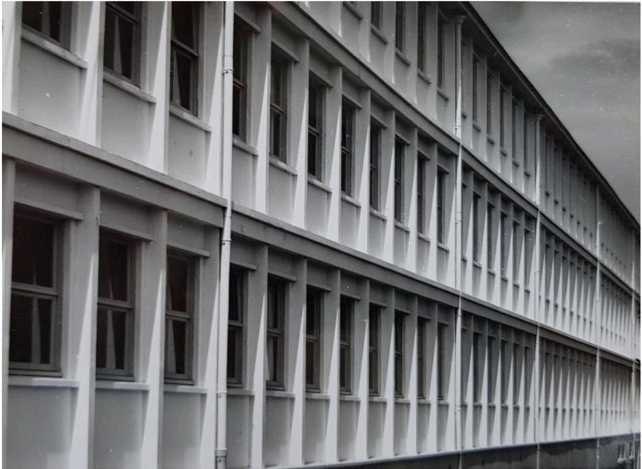
Détail sur la trame de la façade des internats. Le principe constructif (poteaux et poutres en béton forment la structure, trame régulière de 1,75m, répétition des modules fenêtre - allège...) est très lisible. (Yves Guillou architecte, photo ca. 1963).
