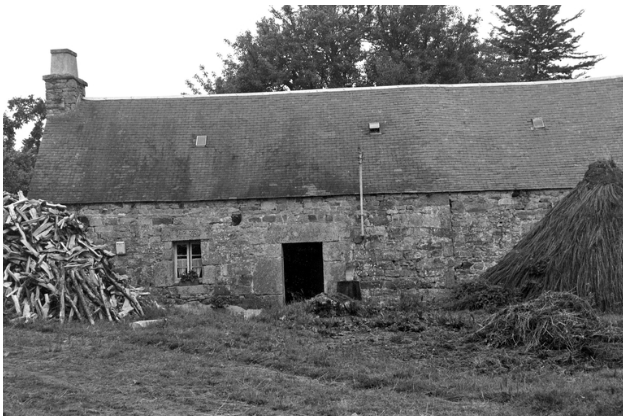
Vue de la façade est
