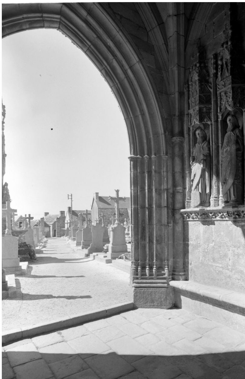
Porche, intérieur : angle sud-ouest
