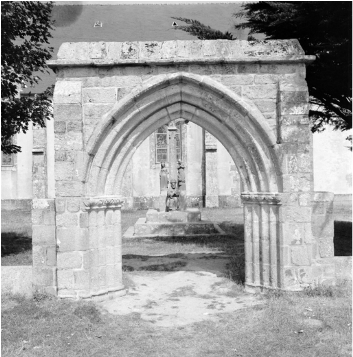
Plonévez-Porzay, chapelle Sainte-Anne-La-Palud : portail sud de l'enclos, état en 1969
