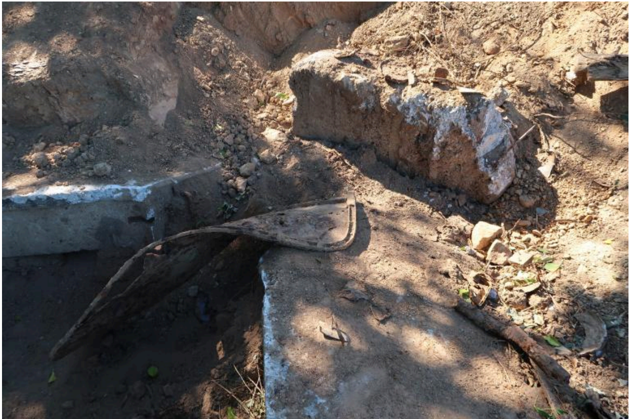
Vue de détail (août 2022, chantier en cours)
