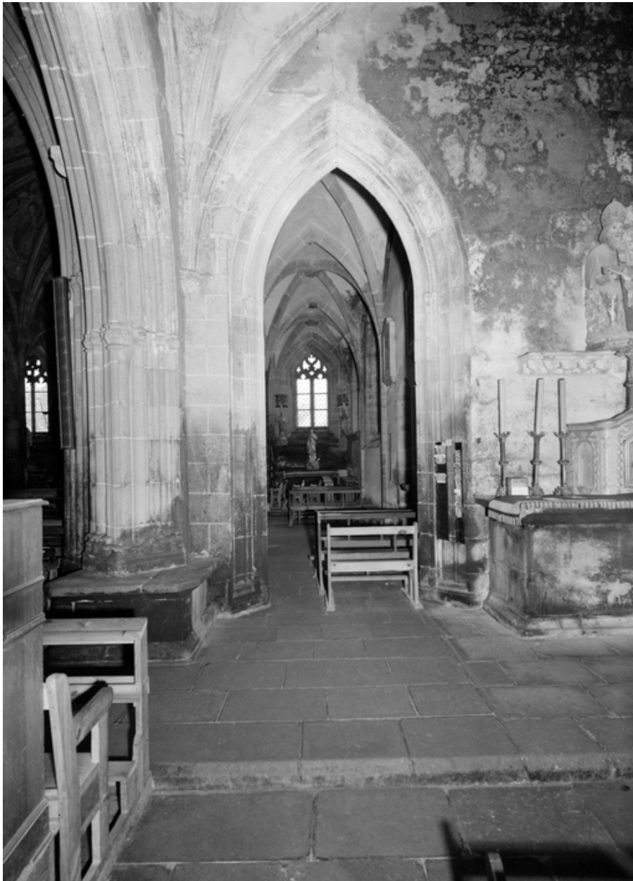
Bas-côté sud (du mur ouest).
