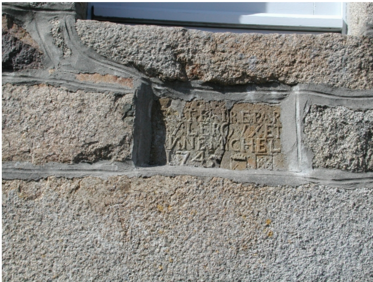
Vue de détail d'une pierre gravée dans la maçonnerie de la façade principale : Gilles Leroux et Anne Michelle, avec la date de 1745 (inscription)
