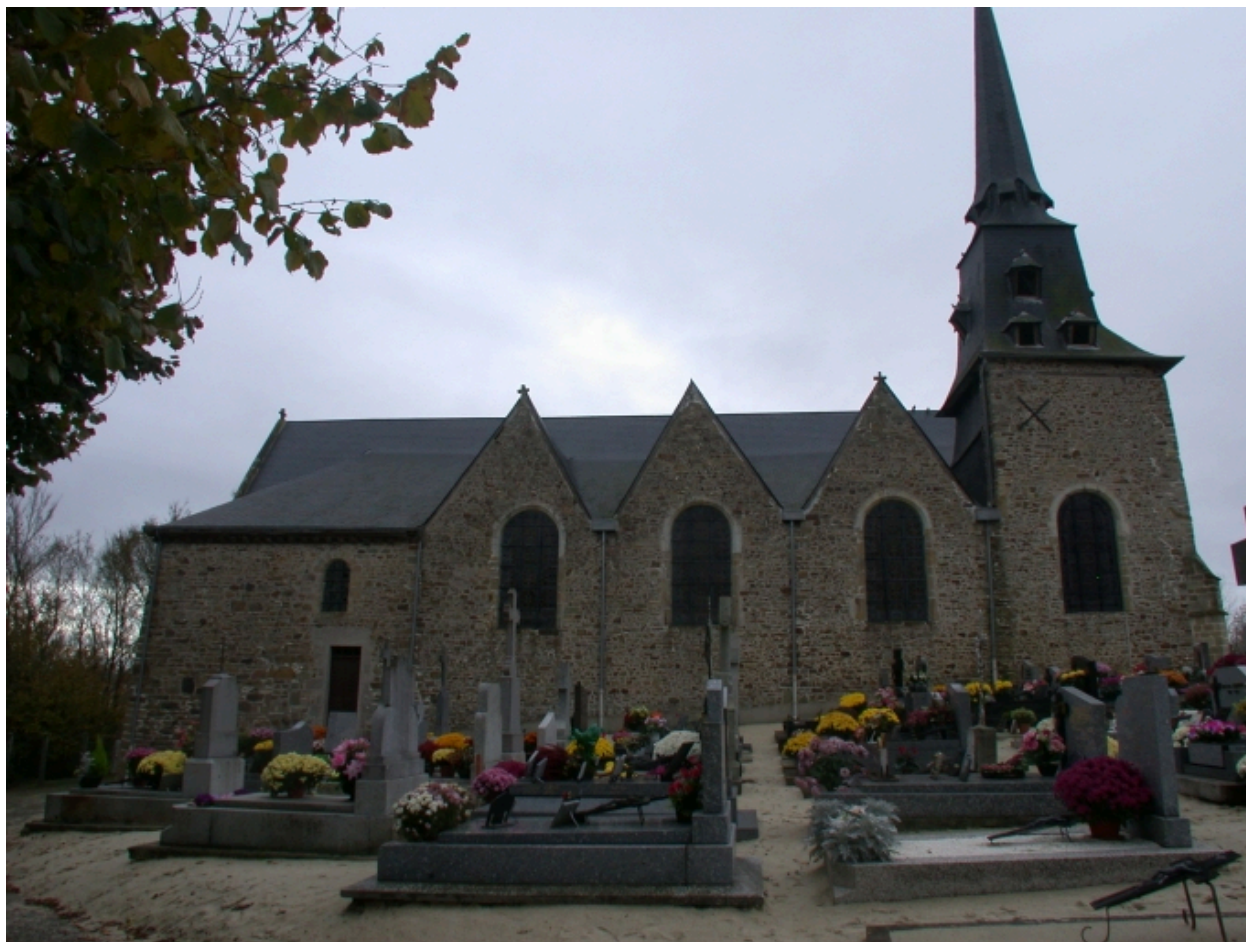
Vue générale nord
