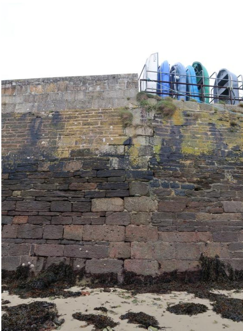
Jonction entre le quai et la cale Est du Drellac'h : maçonnerie différenciée
