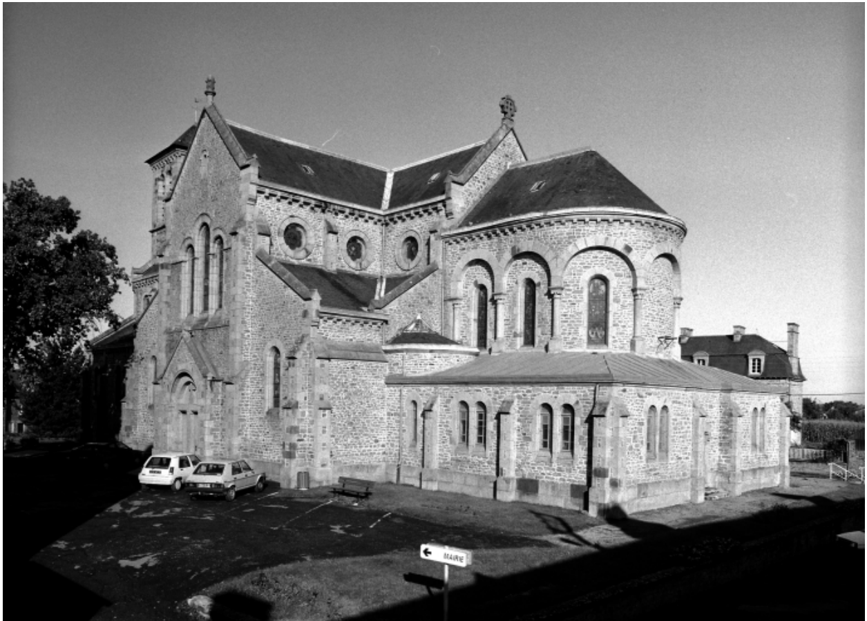
Elévation Sud-Est : vue générale
