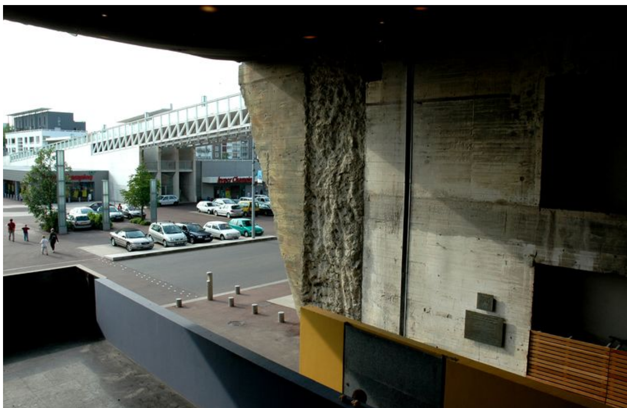
Vue de l'intérieur de la base de sous-marins : descente par le nouvel escalier
