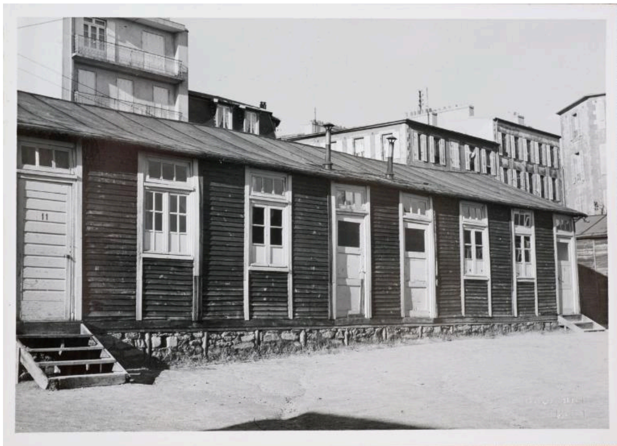
Baraques du collège technique, "Place Sanquer". (Entre guillemets, légende au dos de la photo).
