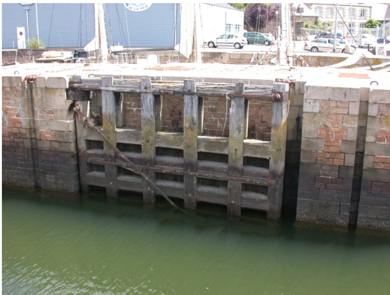
Vue de l'ancienne porte en bois de la 1ère écluse, en amont, hors service
