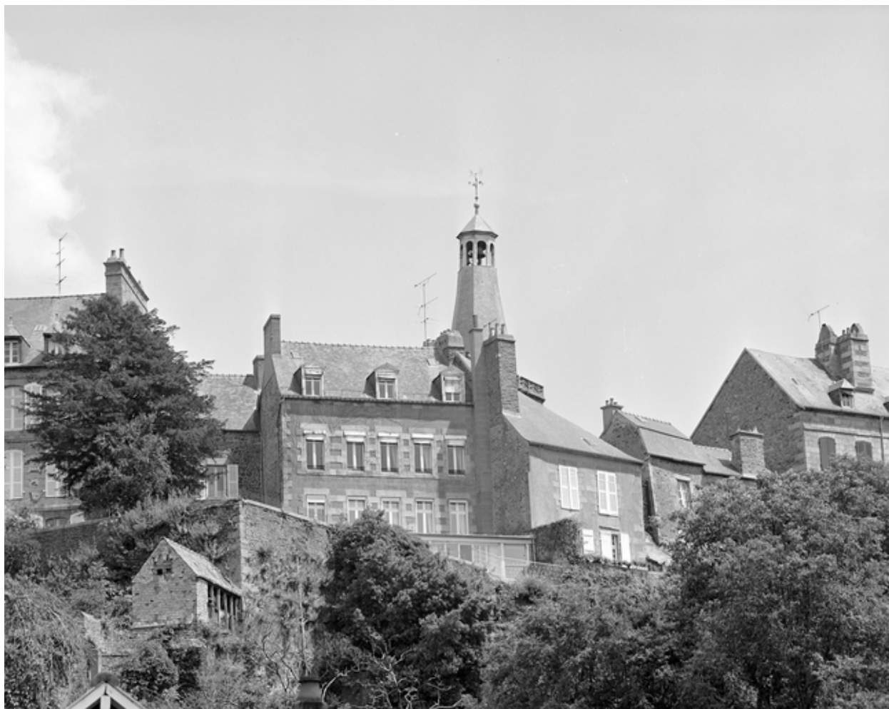
Ville Haute, vue centrée sur la maison 15 rue du Beffroi.
