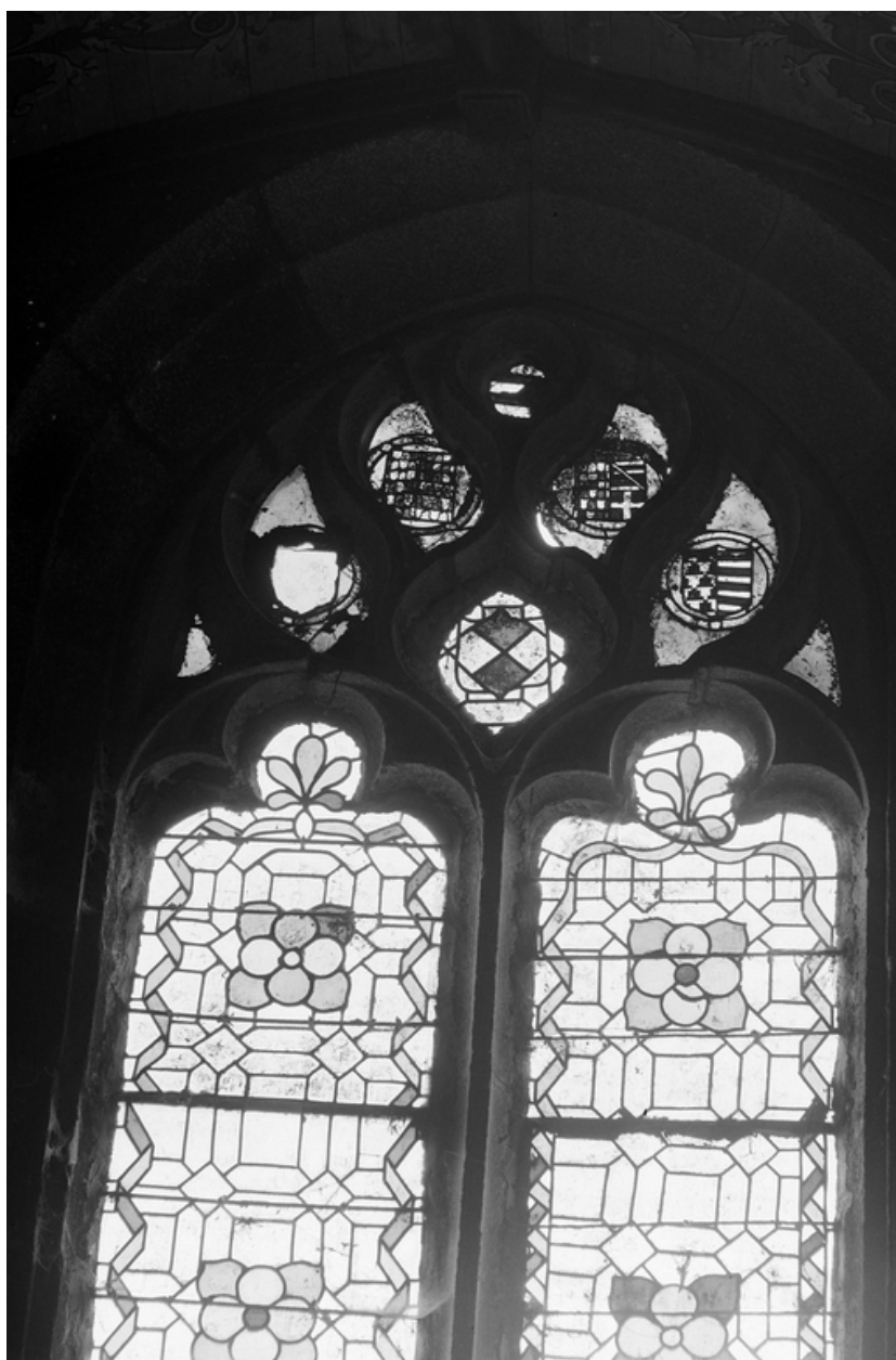
Croisillon occidental nord, fenêtre du mur nord (7) : détail du remplage et des armoiries
