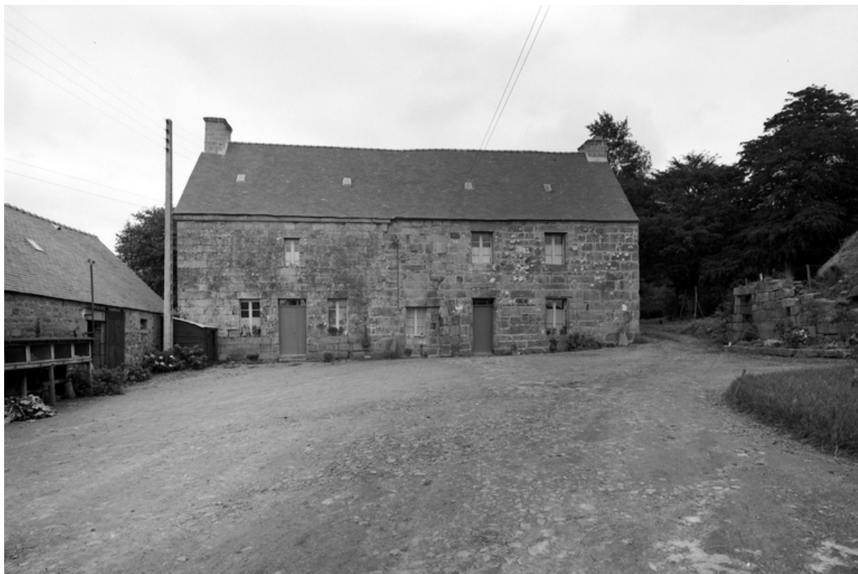
Vue générale de la face antérieure
