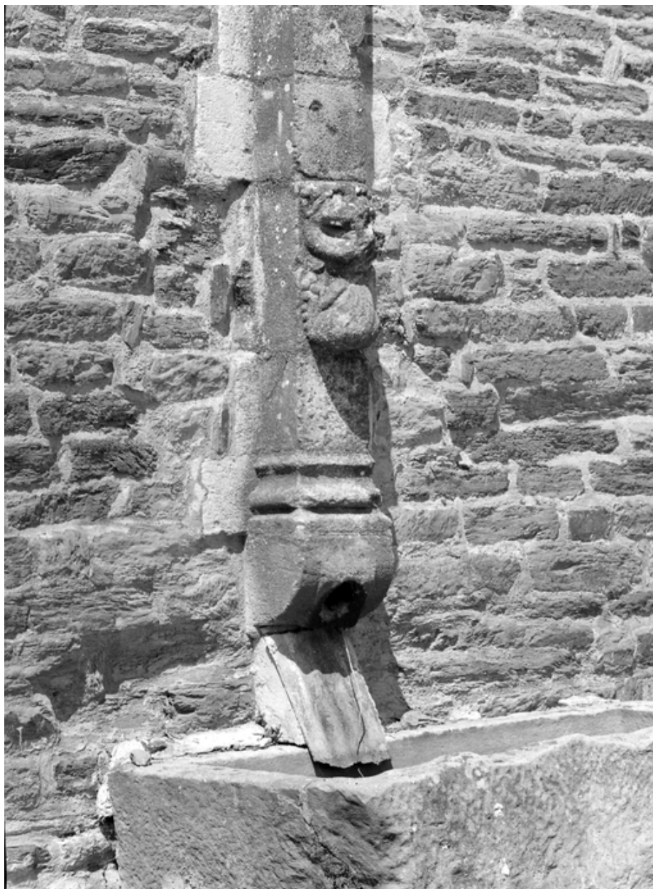
Aile nord, côté cour, quatrième tuyau de descente.
