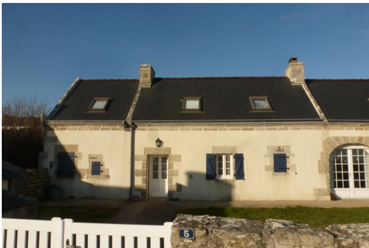
Maison 1, élévation antérieure du logis daté 1841 et d'une crèche accolée.
