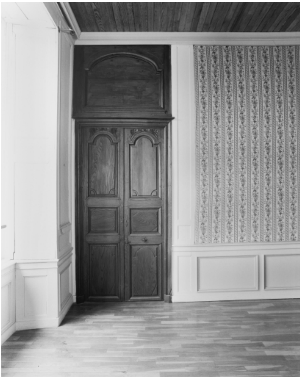
Etage, partie sud, pièce nord : vantail de porte
