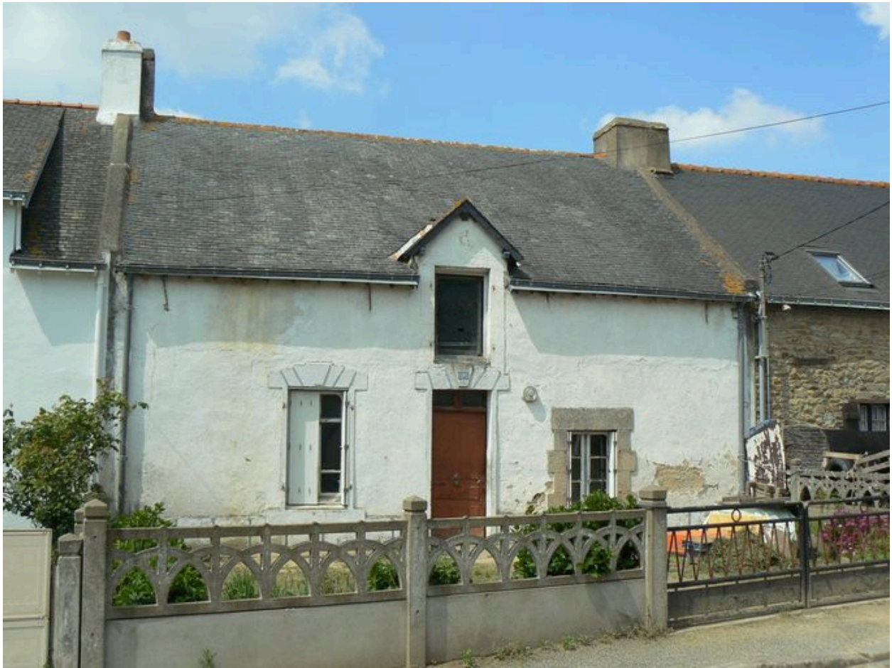
Vue générale de la maison de pêcheur du 8 rue des Algues
