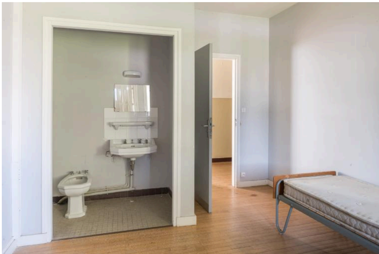
Chambre de deux lits et salle d'eau, au premier étage.
