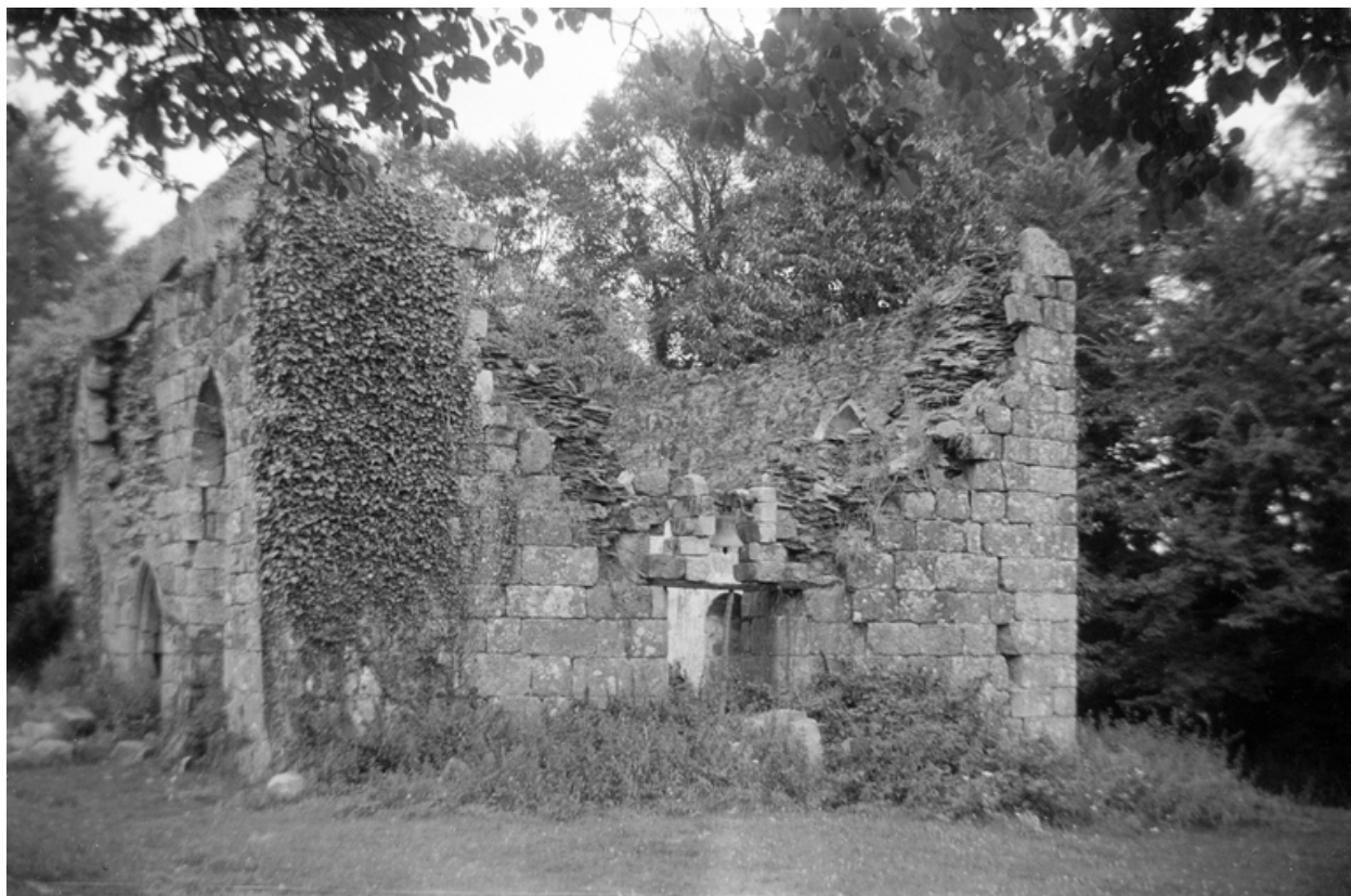
Façade occidentale : état vers 1955
