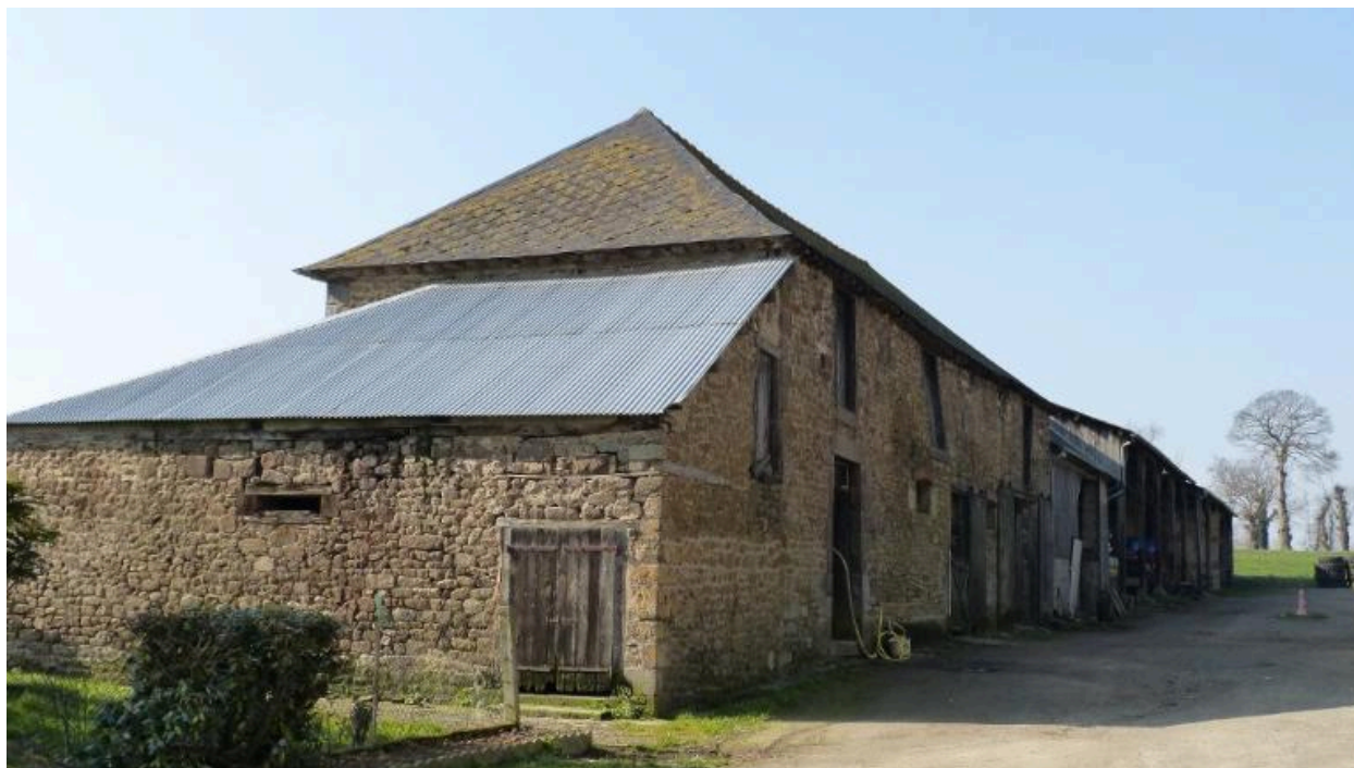
Vue générale nord est des dépendances
