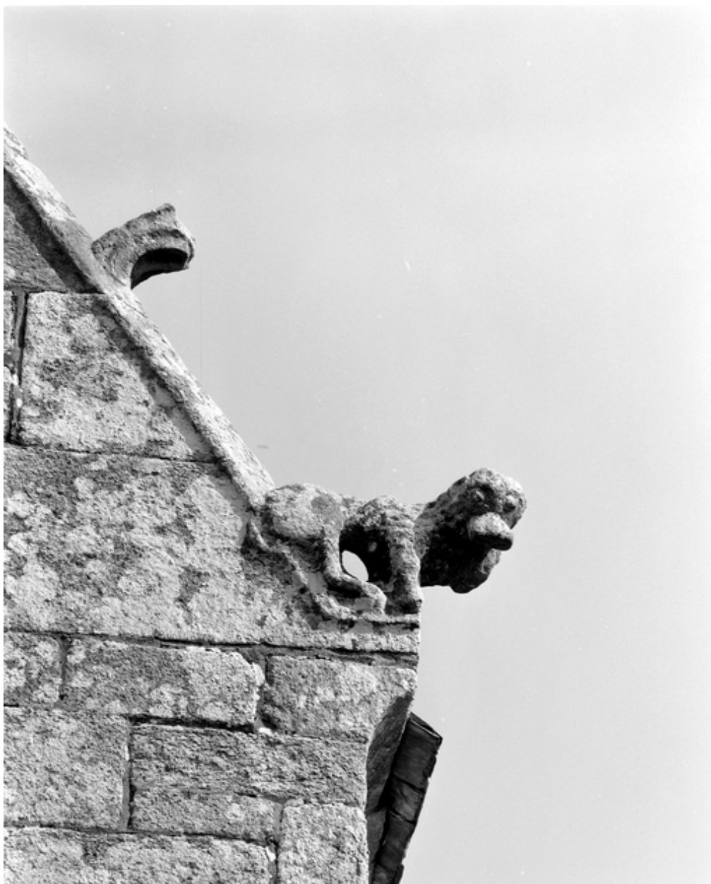
Bras sud du transept : détail de la pierre d'assise du rampant du pignon est
