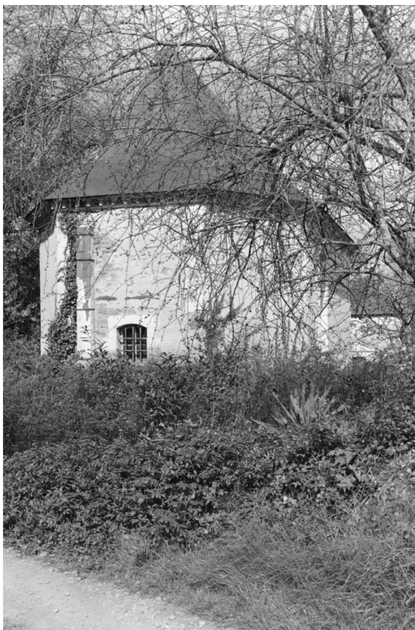
Chapelle, vue générale, face ouest.
