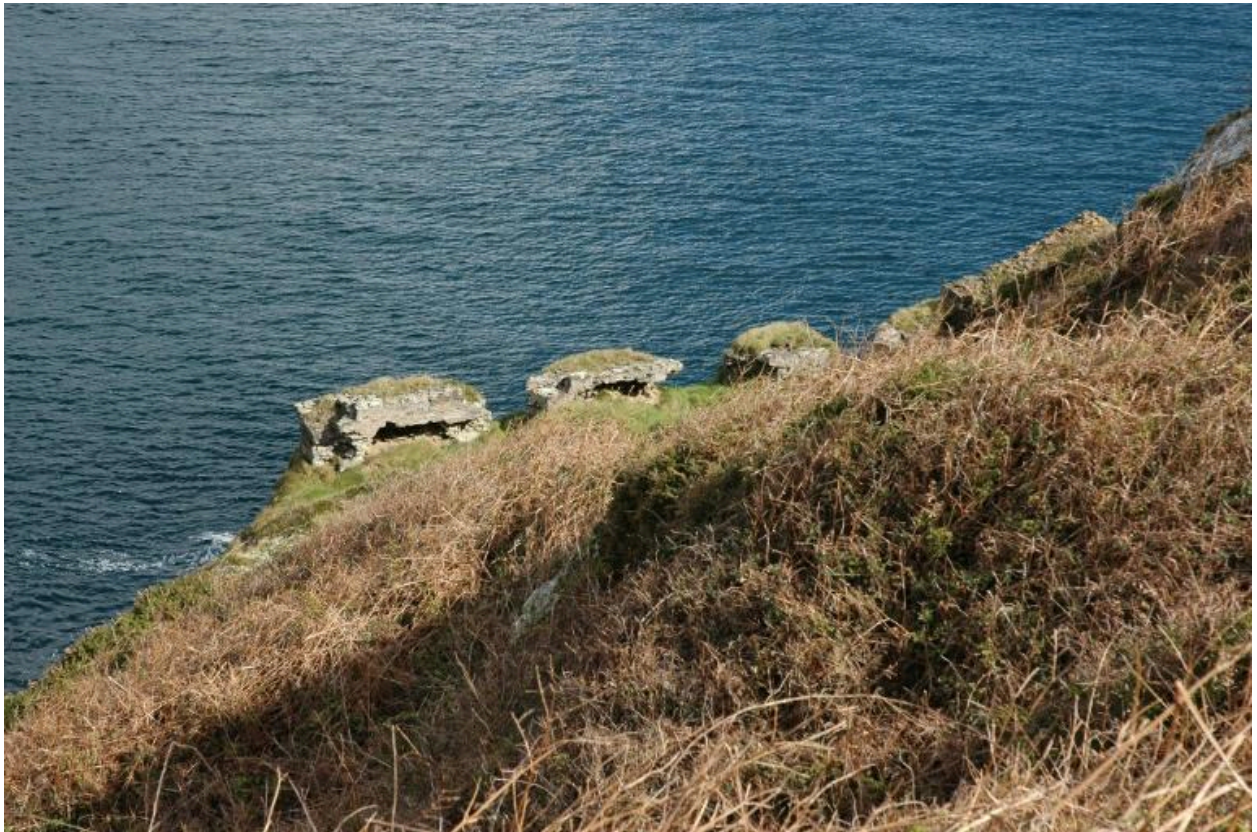
Vue des vestiges du parapet percé d'embrasures (état en 2005)
