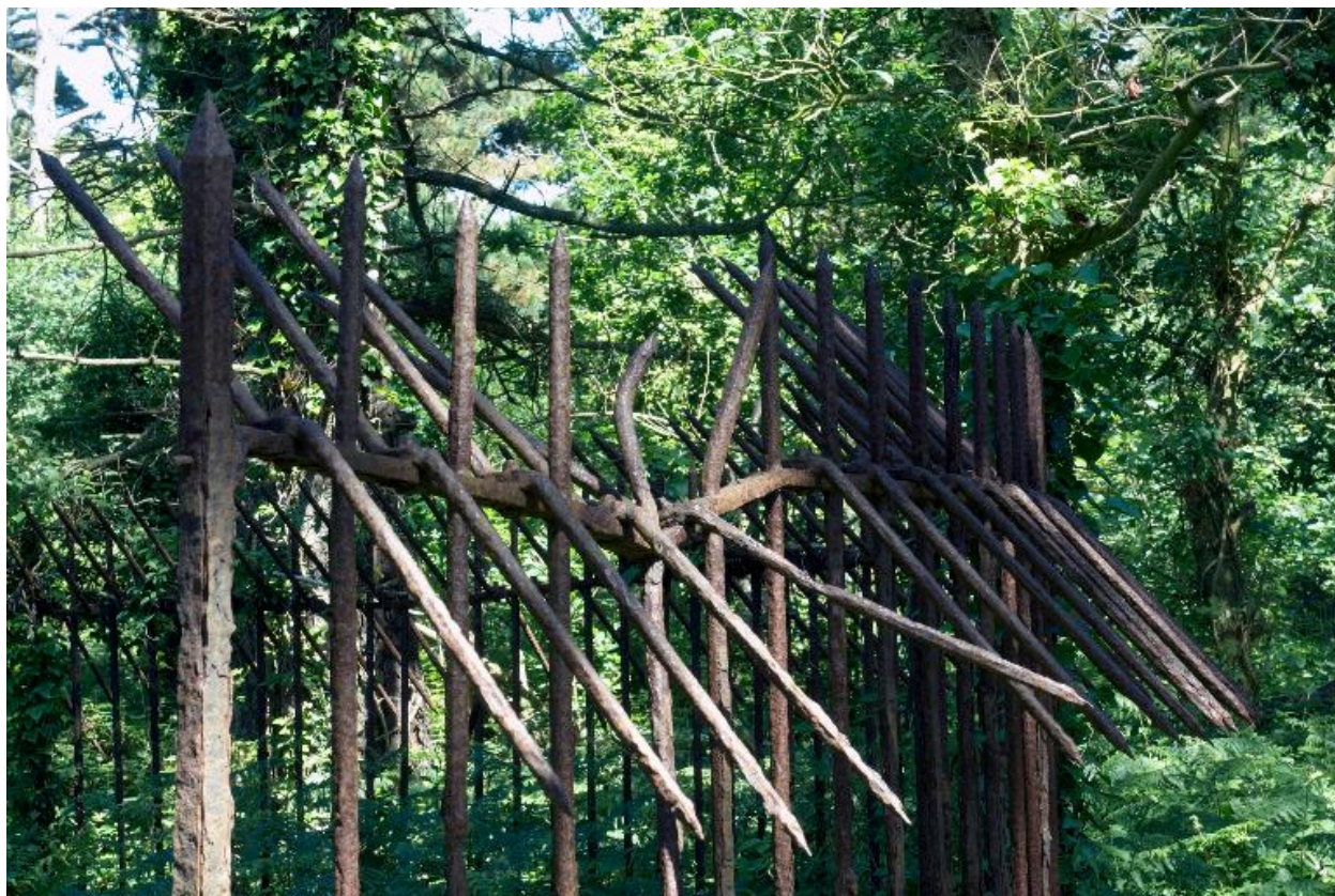
Vue des grilles défensives du magasin à poudre sous roc
