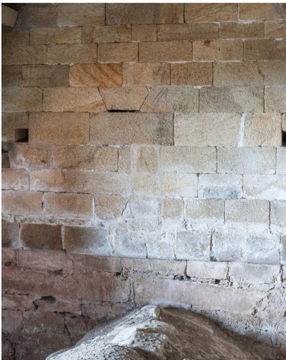
Vue du revers du pignon sud de l'abside.
