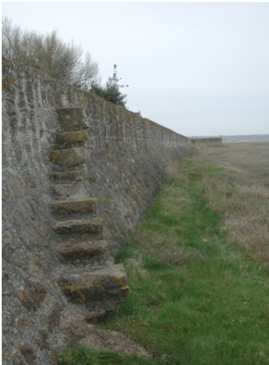
Vue de l'escalier de la digue
