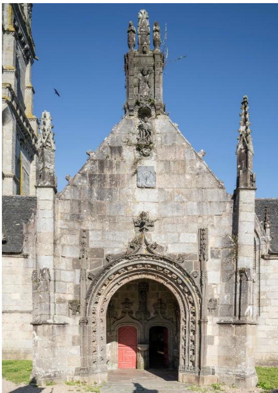
Porche sud, vue depuis le sud
