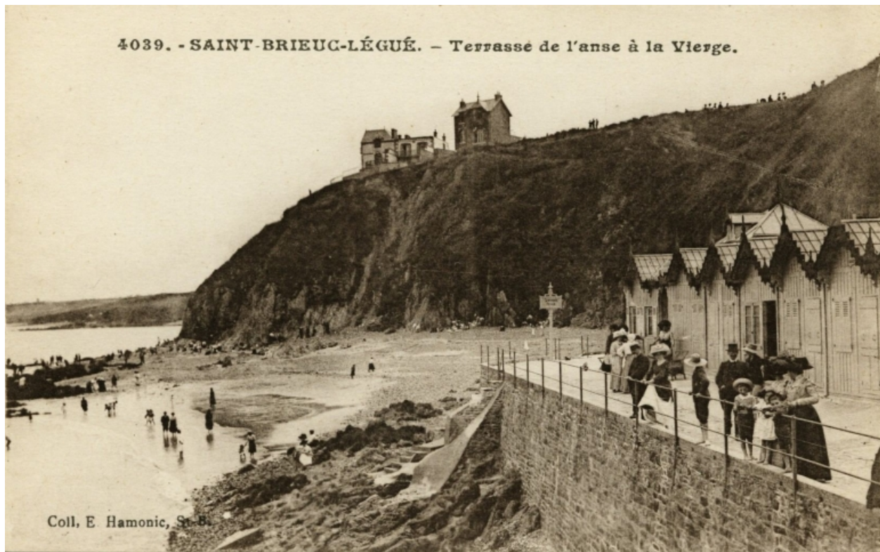
La digue-terrasse-promenade vers 1917-1925 (carte postale, AD 22)
