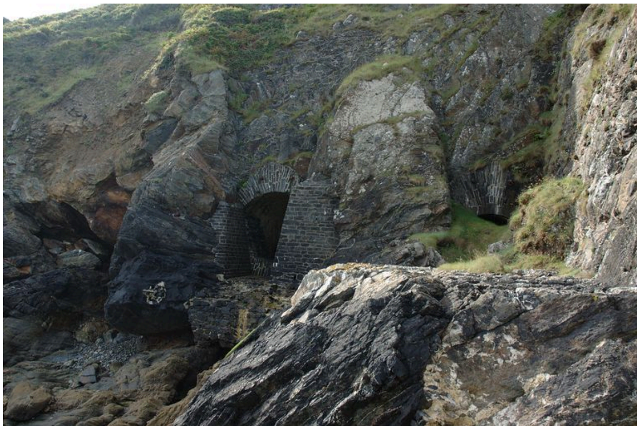
Vue des deux embrasures de la batterie casematée de la pointe Robert (état en 2007)
