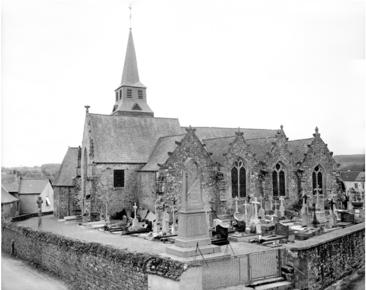
Elévation Nord : vue générale
