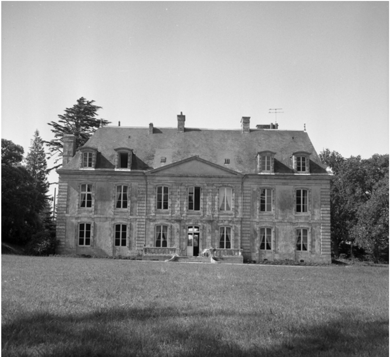
Elévation nord, vue générale. Etat en 1974.
