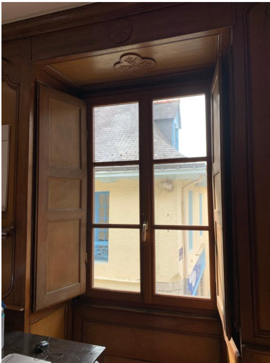
Partie ouest, premier étage, salon avec boiserie, détail de la fenêtre
