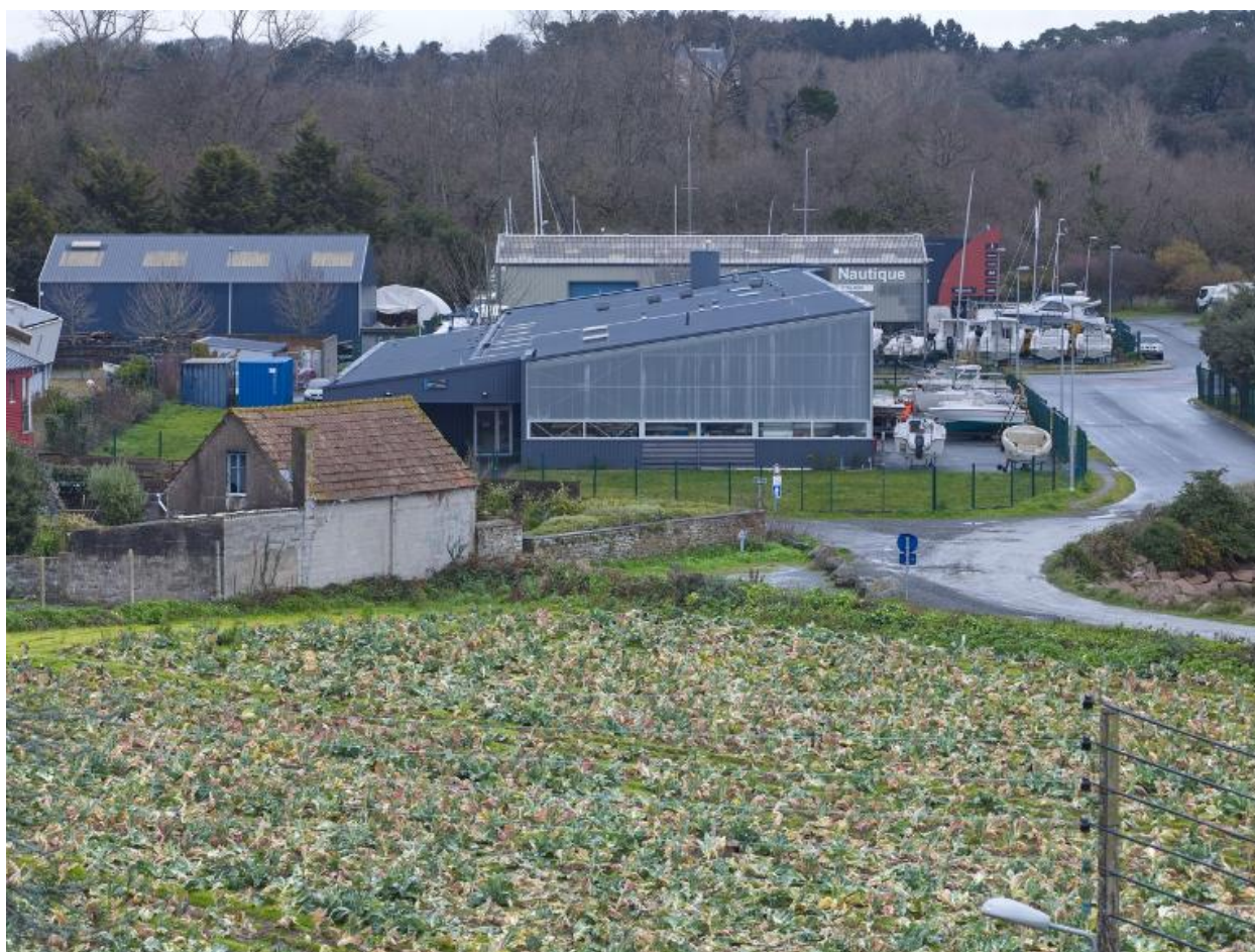
Vue des ateliers, façade sud, depuis la terrasse nord-est de l'externat.
