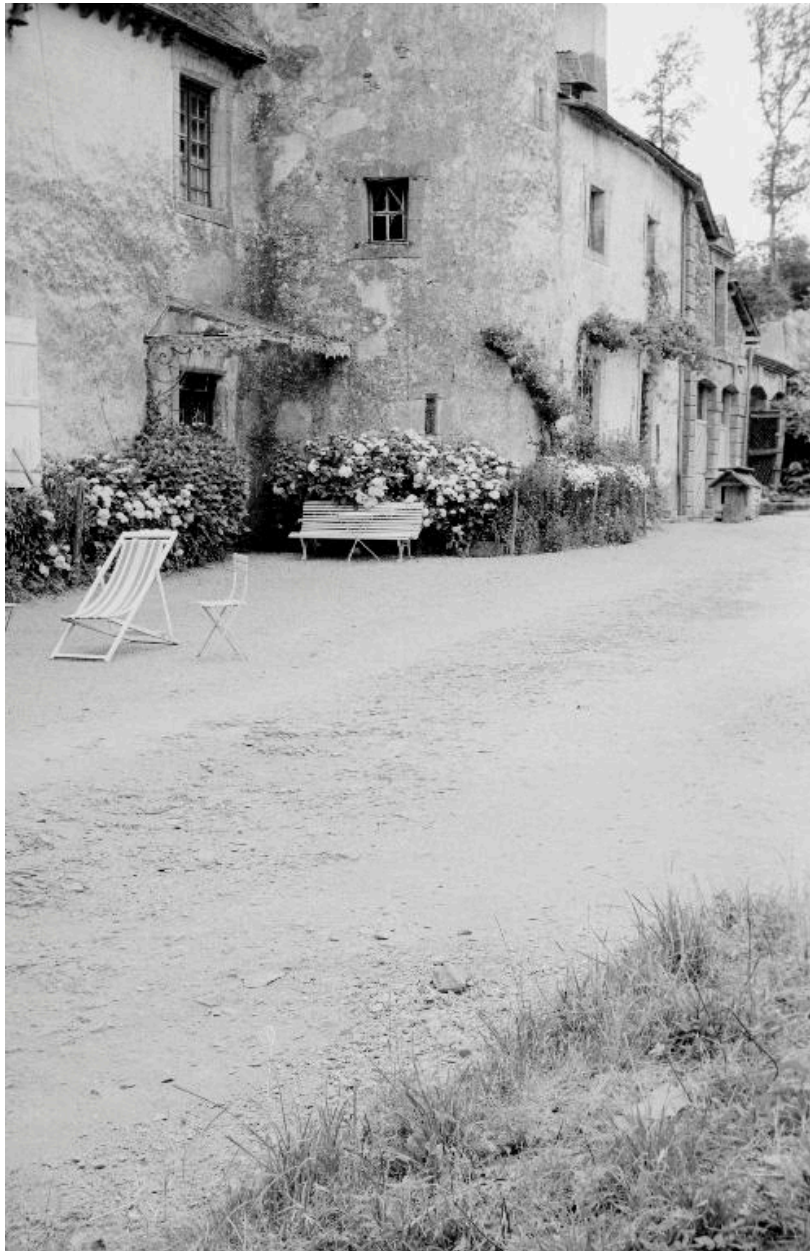
Logis du 17e siècle : vue générale depuis le sud (état en 1969)
