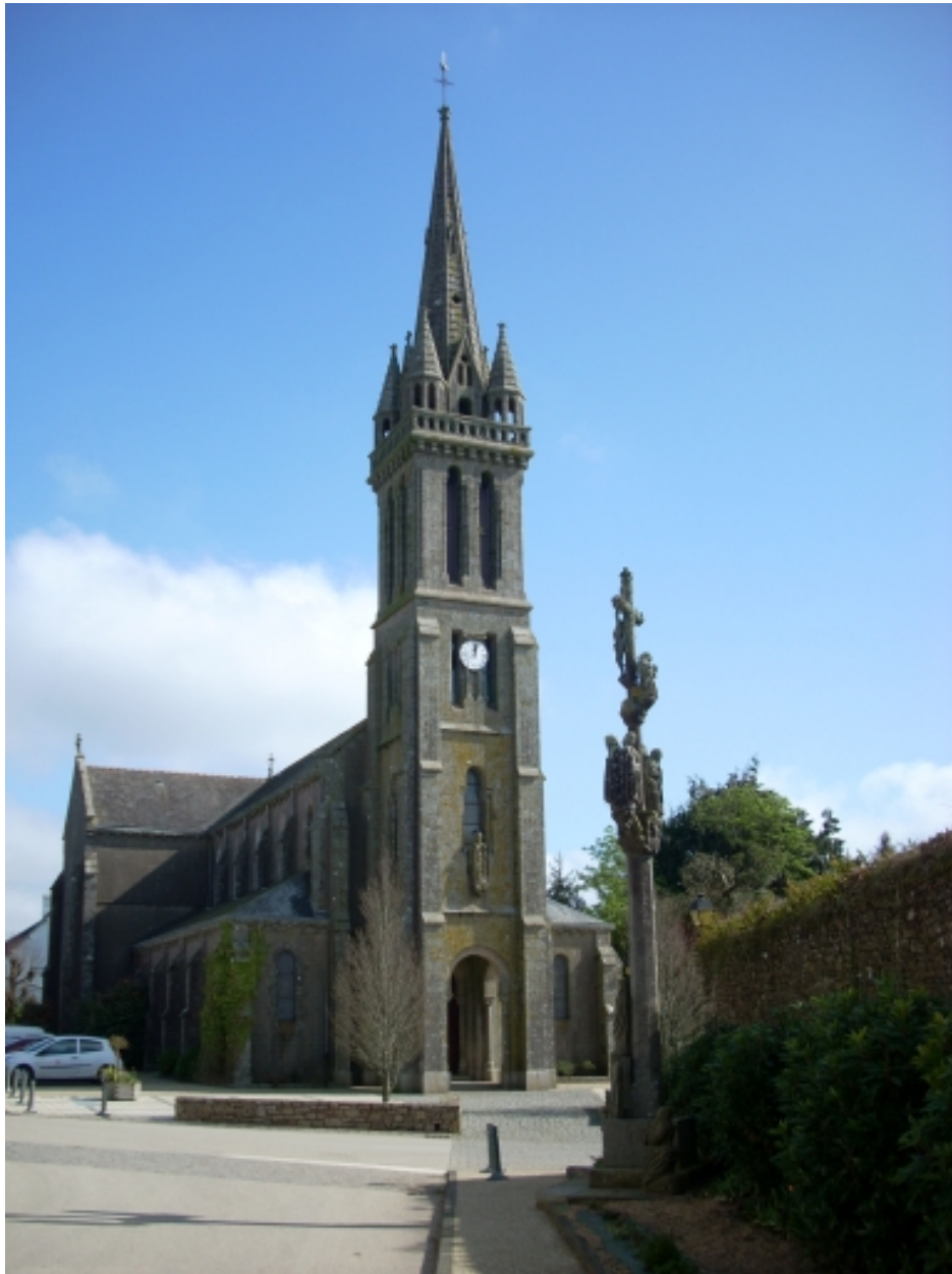
Saint-Ségal, église paroissiale Saint-Séverin : vue générale nord-ouest
