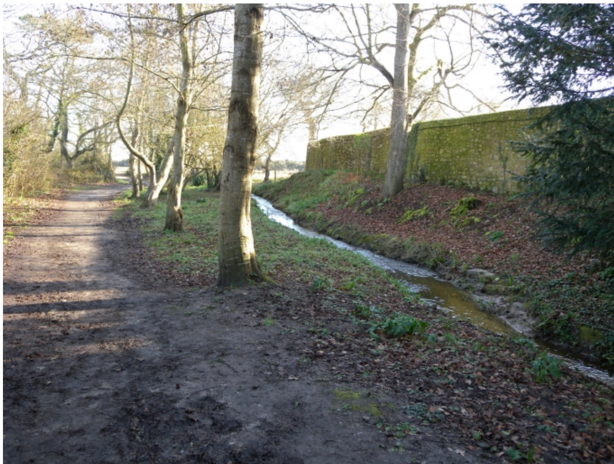
Vue du mur d'enceinte et du circuit de l'eau
