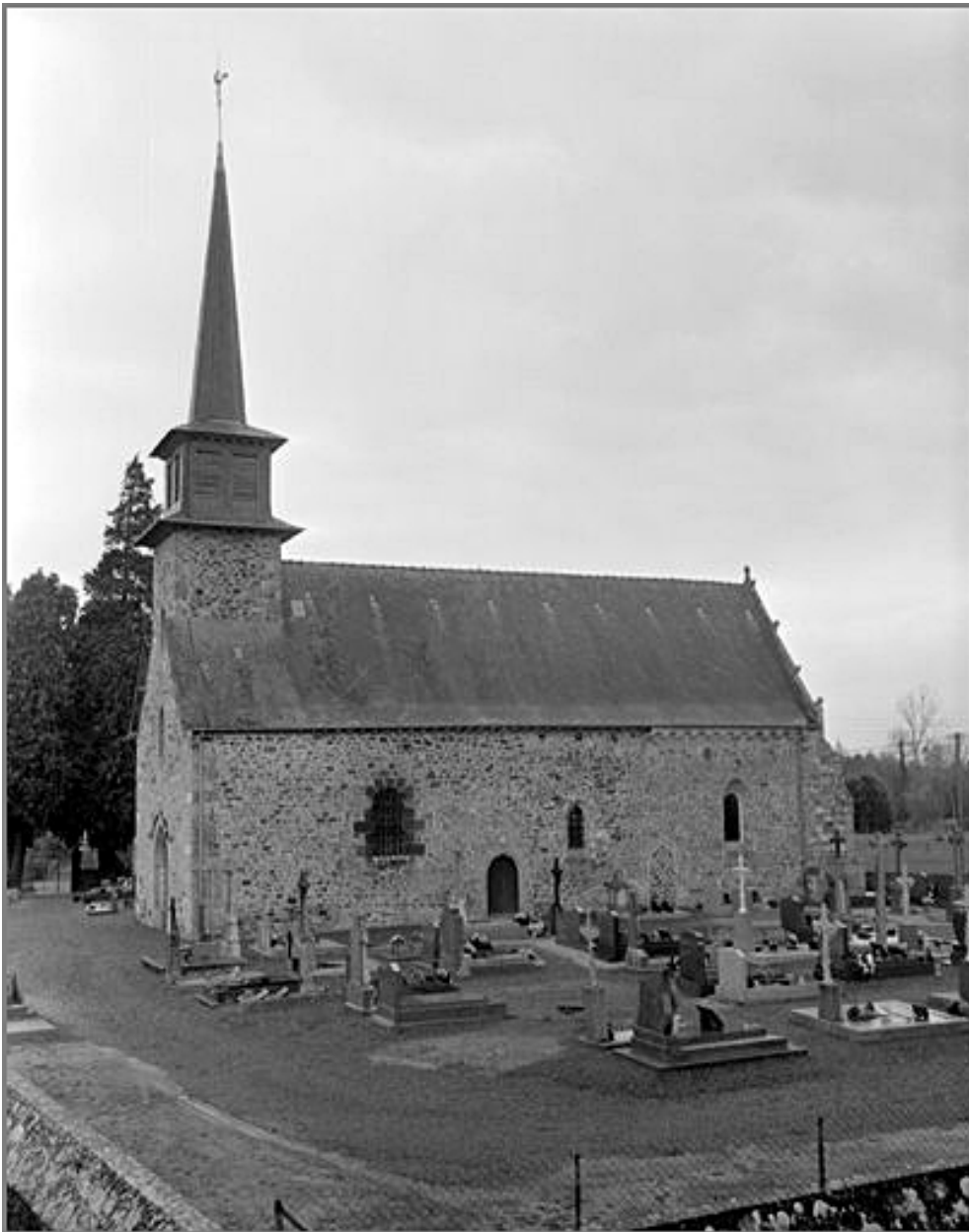
Elévation Sud : vue générale
