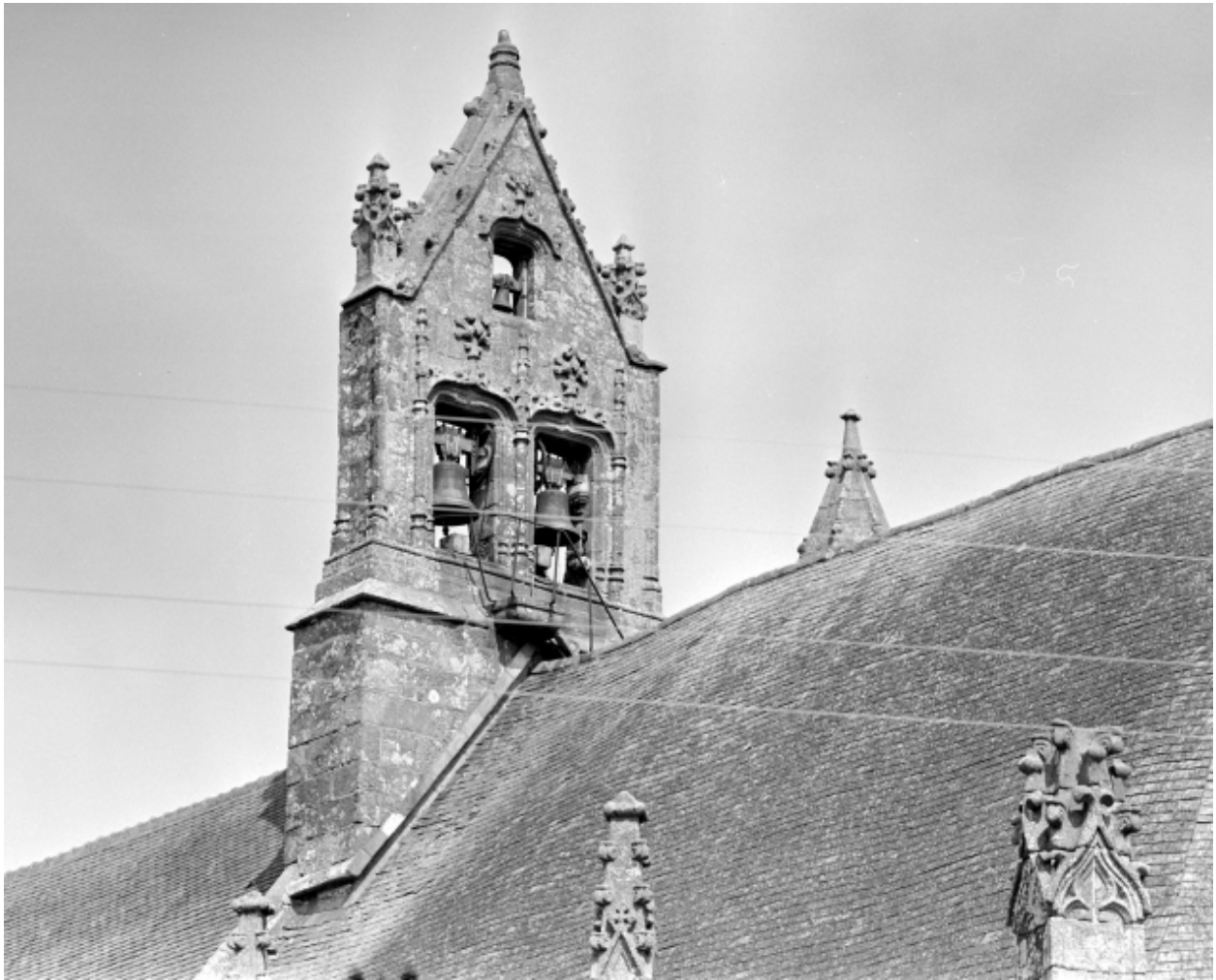
Elévation Est, clocher : vue générale
