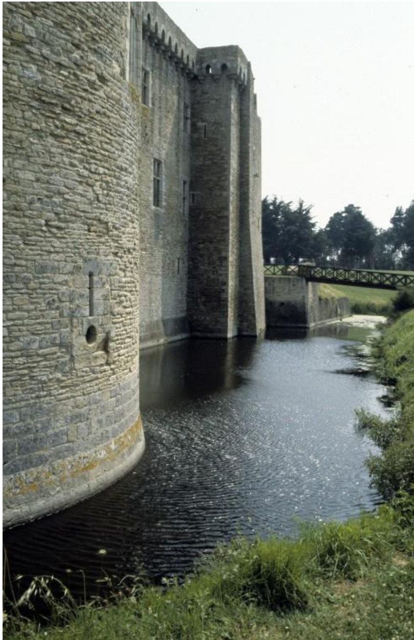
Logis ouest, vue prise du nord.
